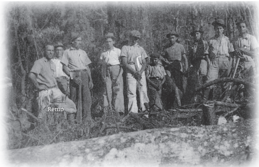
Remo e trabalhadores da Serraria Ferrarese fazendo a derrubada do mato para instalação da empresa em Marrecas.
